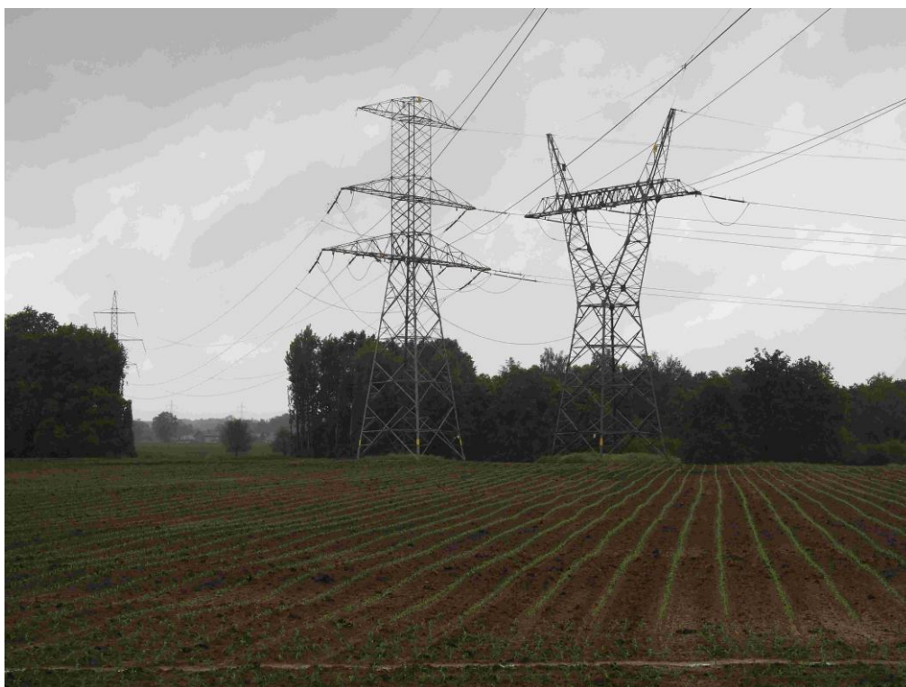
Fot. 6. Istniejąca infrastruktura (np. drogi, linie elektryczne) pozwoli na zrealizowanie inwestycji bez dodatkowej ingerencji w przyrodę.
