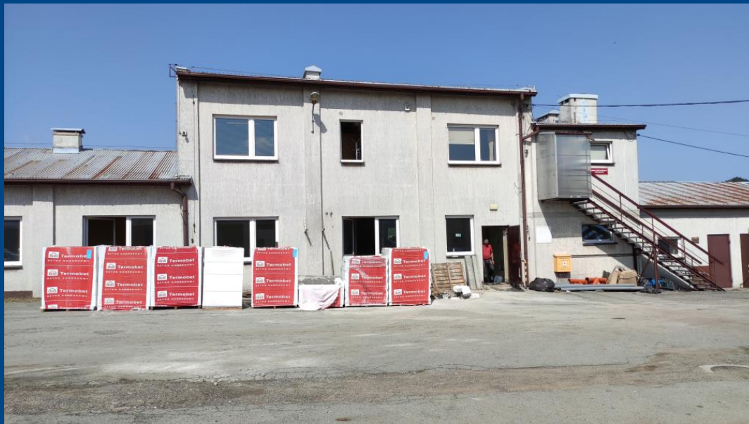
Rozbudowa budynku GZK w Pawłowicach wraz z zagospodarowaniem terenu. Planowane zakończenie inwestycji: kwiecień 2024 r. Koszt: 3 280 000 zł
