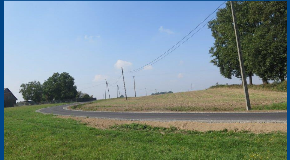
Przebudowa ul. Stawowej - Warszowice
