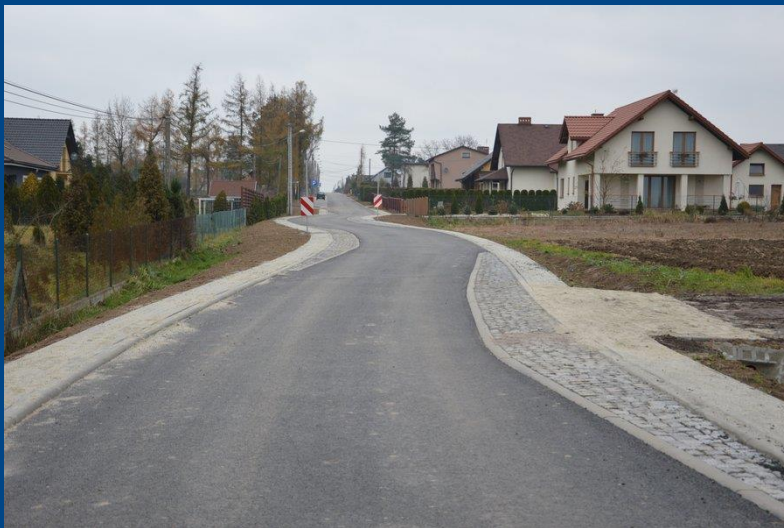
Przebudowa ul. Konopnickiej - Golasowice
