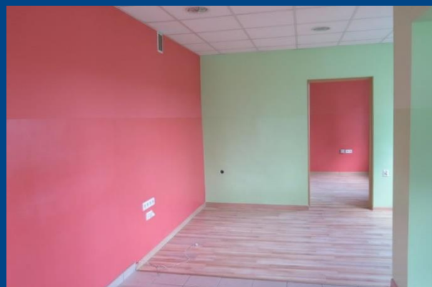
Remont pomieszczeń dla sołtysa i rady sołeckiej Warszowice
