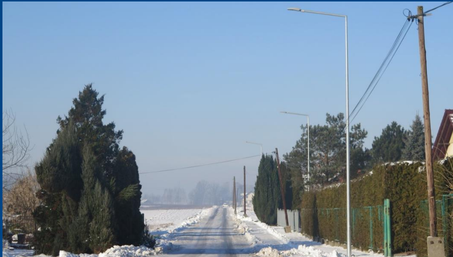
Oświetlenie przy ul. Kanarkowej Pniówek
