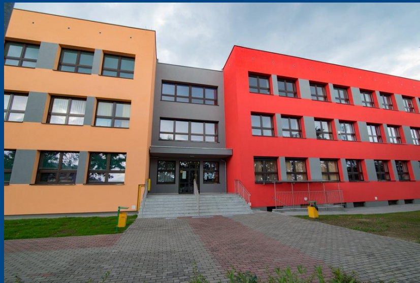
Termomodernizacja SP nr 2 i przebudowa systemu wentylacji kuchni i jadalni Osiedle Pawłowice
