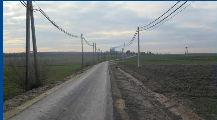
Przebudowa ul. Granica – z dofinansowaniem (dojazd do gruntów rolnych ) Pawłowice - Warszowice
