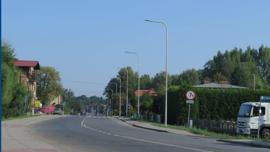
Oświetlenie ul. Zjednoczenia (48 lamp) Pawłowice
