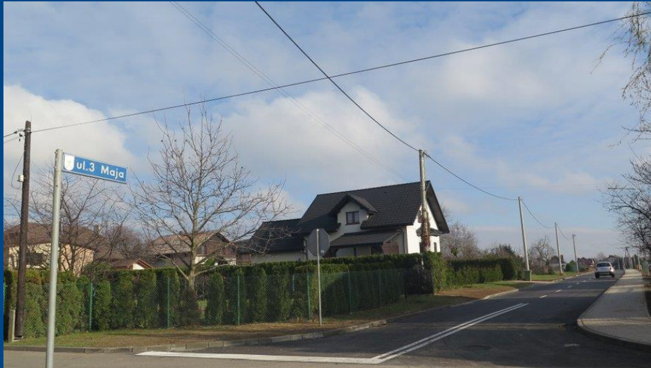
Budowa ul. 3 Maja - Pawłowice
