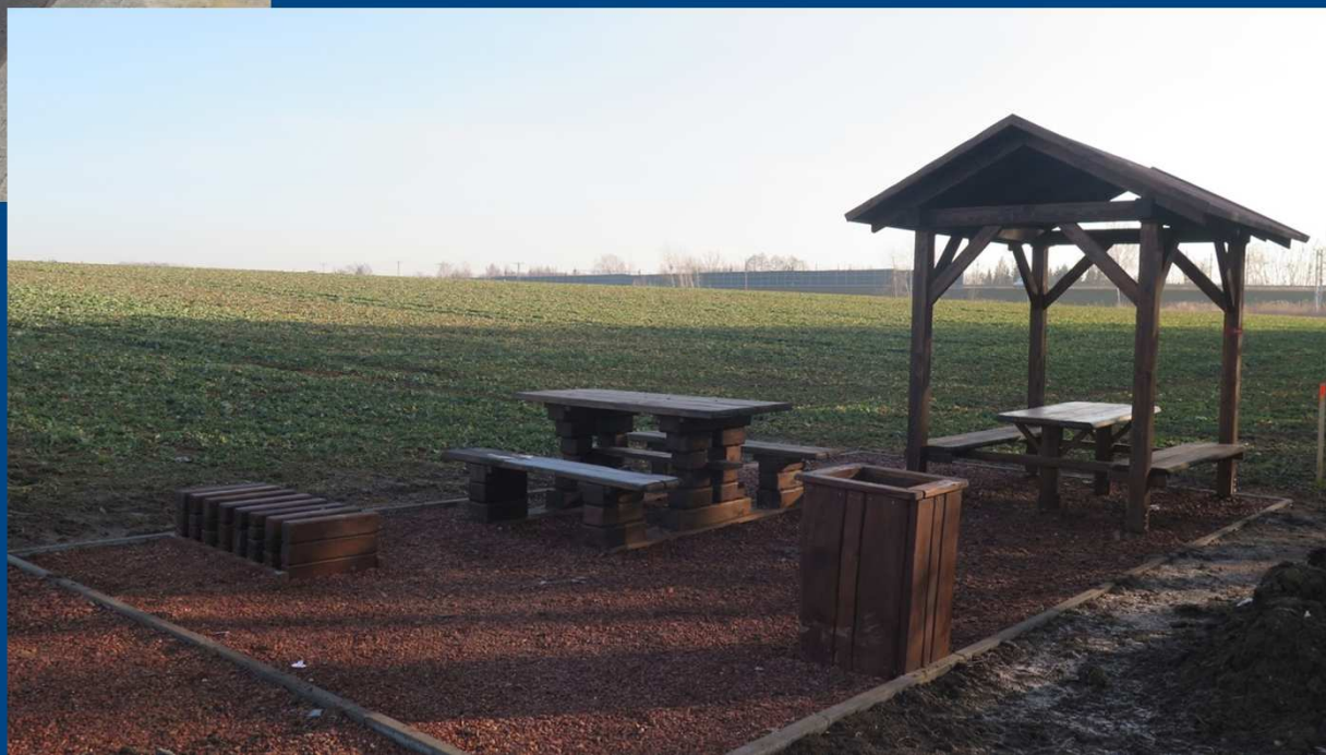
wykonanie punktu odpoczynkowego dla rowerzystów przy ul. Nowej
