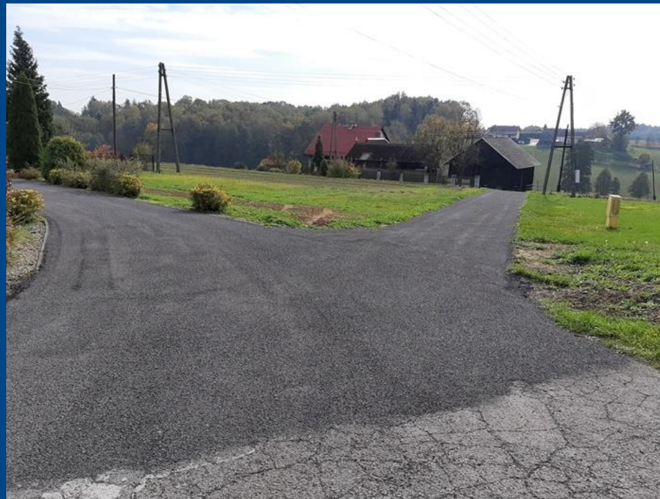
boczna ul. Groblowej na odcinku 180 m,
